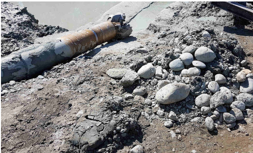
Ghiaie e ciottoli dello strato superficiale e realizzazione dei corridoi di sostituzione delle ghiaie, tramite scavo sostenuto da palancolati e getto della miscela cementizia
