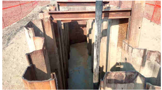
Ghiaie e ciottoli dello strato superficiale e realizzazione dei corridoi di sostituzione delle ghiaie, tramite scavo sostenuto da palancolati e getto della miscela cementizia
